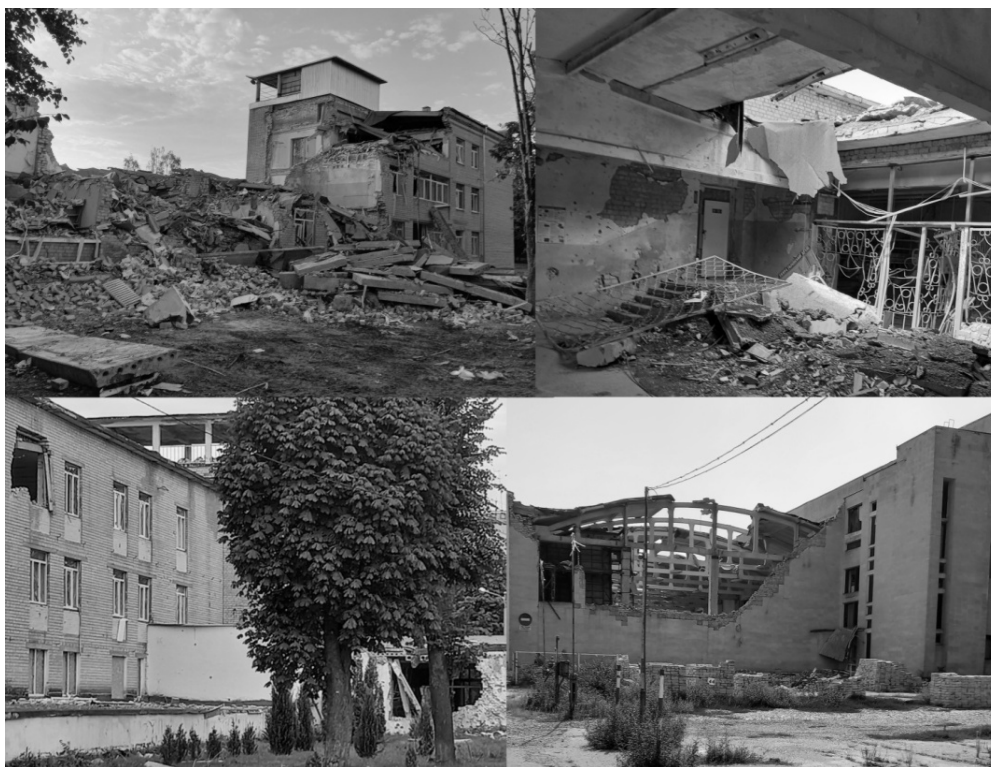
Рис.2 Пошкоджені та зруйновані навчальні заклади Харкова (фото авторів)
